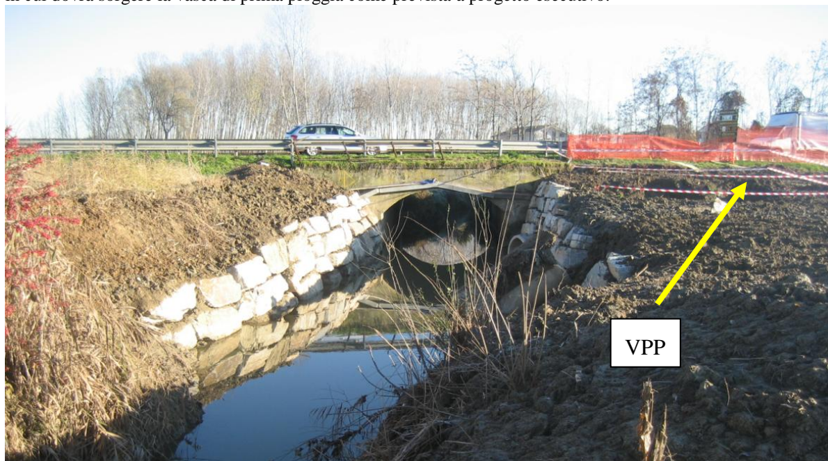
Fig. 2 – Rio Scarosa – Particolare dei lavori di sistemazione dell'alveo allo sbocco della fognatura e dell'area in cui dovrà sorgere la vasca di prima pioggia come prevista a progetto esecutivo.
