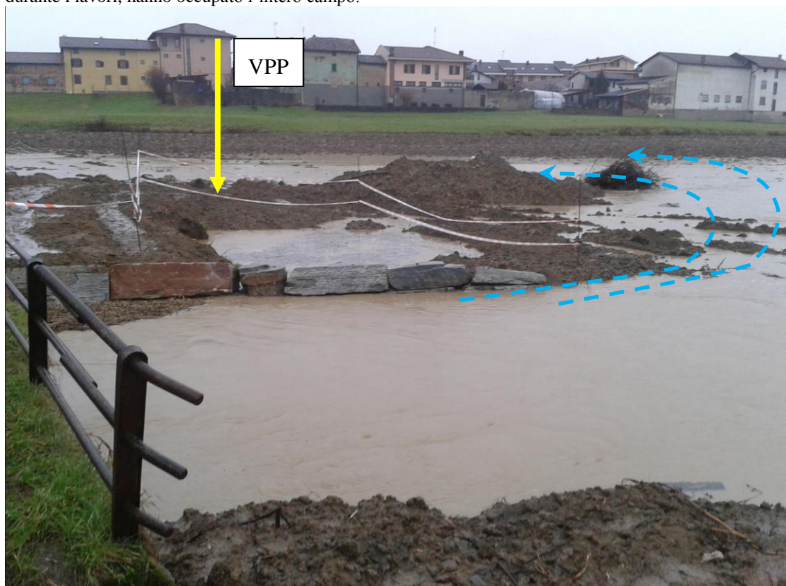
Fig. 3 Evento alluvionale del 24-26 dicembre 2013. Si noti come l'area in cui dovrebbe essere installato l'impianto di prima pioggia risulti completamente allagata. Le acque, aggirato il rilevato provvisorio realizzato durante i lavori, hanno occupato l'intero campo.
